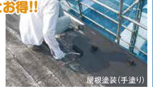
屋根塗装(手塗り)
