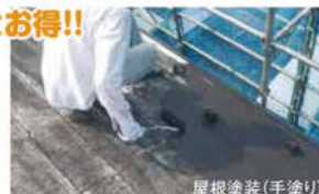
屋根塗装(手塗り)
