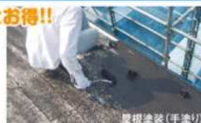
屋根塗装(手塗り)
