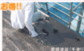
屋根塗装(手塗り)
