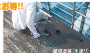
屋根塗装(手塗り)
