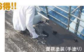
屋根塗装(手塗り)
