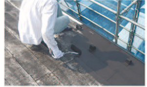
屋根塗装(手塗り)
